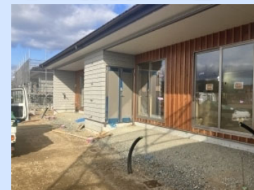
大熊町公営住宅整備状況
