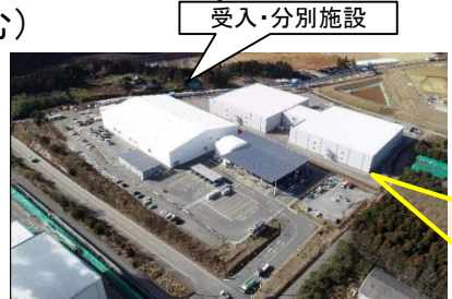
受入・分別施設 外観(大熊町)
