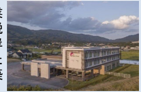
宿泊施設外観 (陸前高田市)
