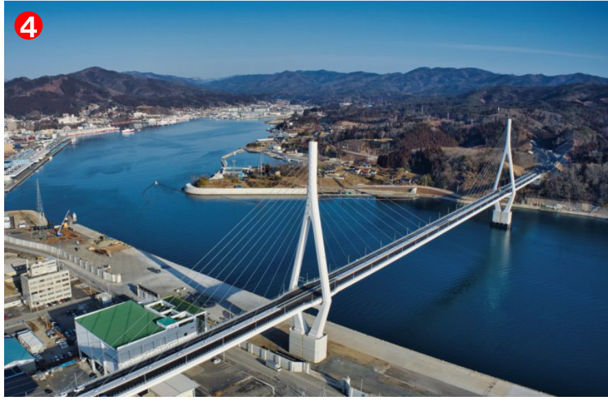
気仙沼湾横断橋（三陸沿岸道路の気仙沼港IC-浦島大島IC間）
