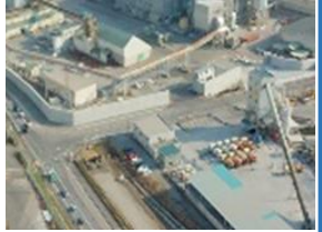
整備中の普金海岸防潮堤 (大船渡市)
