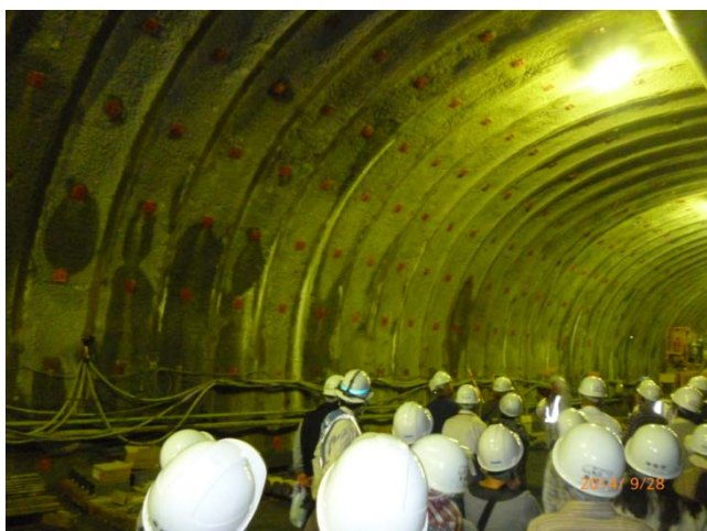
トンネル内の様子
