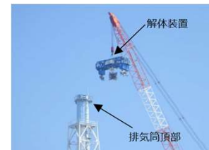
排気筒解体工事の様子
