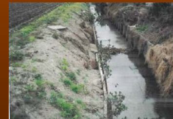
老朽水路の改修
