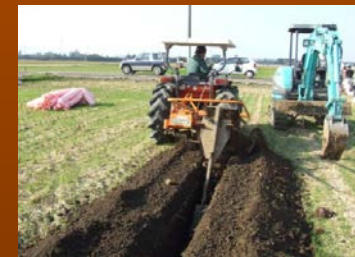
暗渠排水の設置
