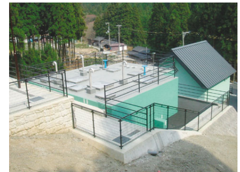
【簡易水道の整備】
