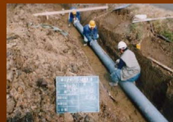
農業用水路の設置
