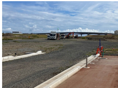
下流側の現状
