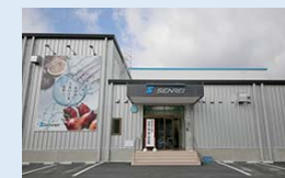
水産加工場外観 (女川町)
