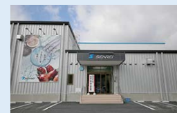
水産加工場外観(女川町)
