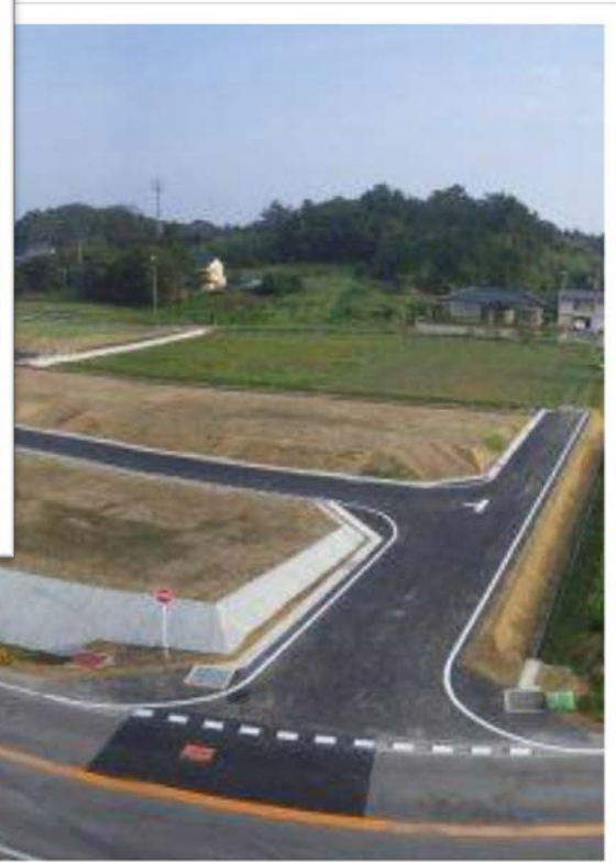
▲ 福島県南相馬市南海老地区(防災集団移転促進事業)
