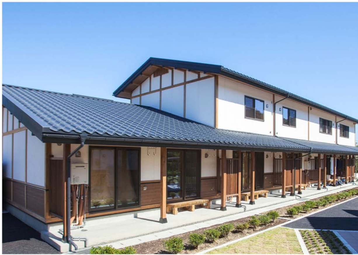
▲ 岩手県大槌町大ヶ口地区 (災害公営住宅)
