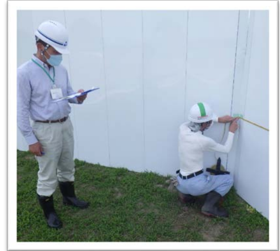
仮置場(仮囲い確認)
