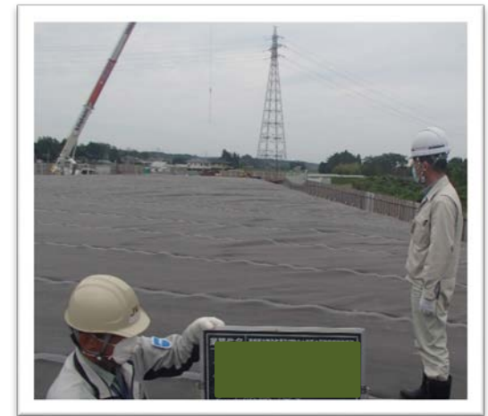
仮置場(除去物格納完了確認)
