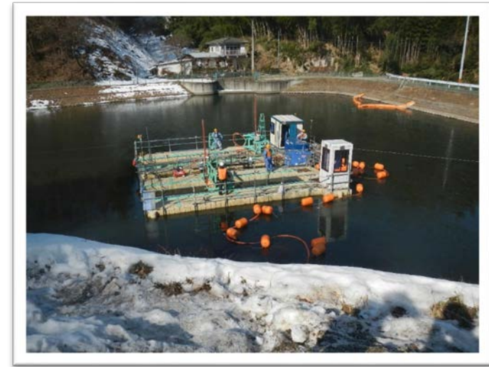
ため池に船を浮かべ、船から水中ポンプで底の泥を引上げ、除染します。
