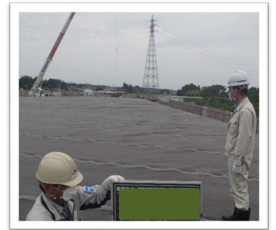
仮置場(除去物格納完了確認)
