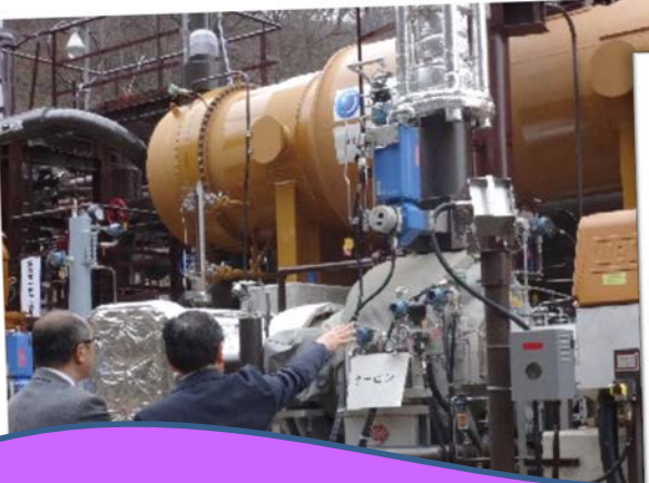
土湯温泉バイナリー発電所 竣工式 (H27.11.20)
