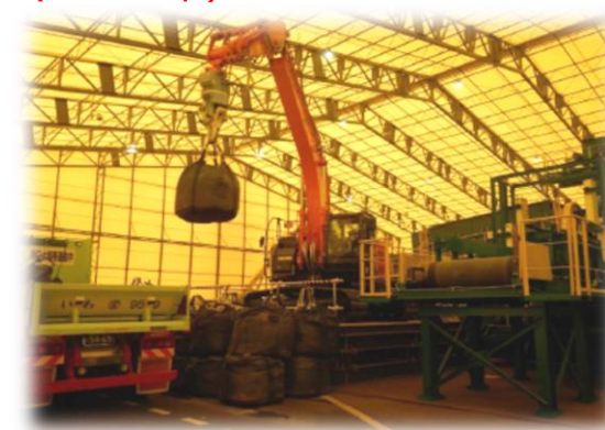
受入・分別施設（1期双葉工区）
