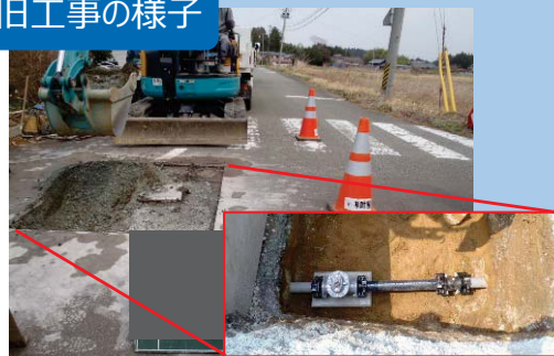
復旧工事の様子
